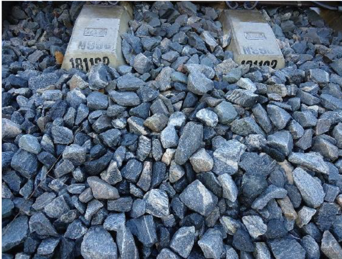
Figuur B2.1 Voorbeeld van ballastbed
