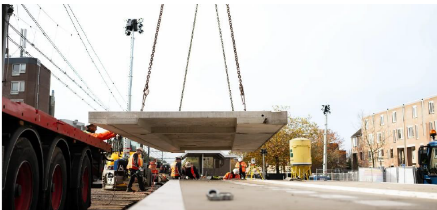
In 2024 zijn de werkzaamheden gestart op Hoorn Kersenboogerd om de perrons te vernieuwen. De nieuwe perrons worden gedeeltelijk verbreed, waardoor er meer ruimte ontstaat voor de reiziger.
