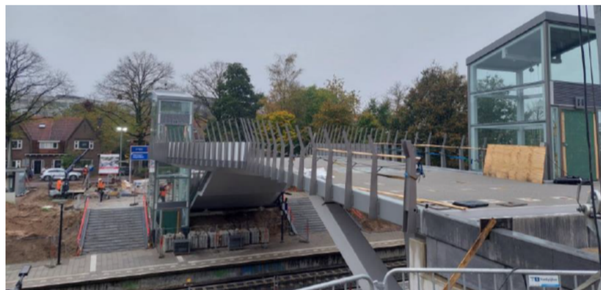
In 2024 startten de werkzaamheden op station Nijmegen Heyendaal. De bredere perrons, een nieuwe oversteek en bredere trappen zorgen voor een betere transfercapaciteit.
