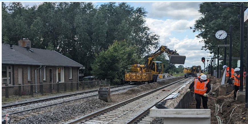
Op station Opheusden werd in 2024 het perron op normhoogte gebracht en vernieuwd.
