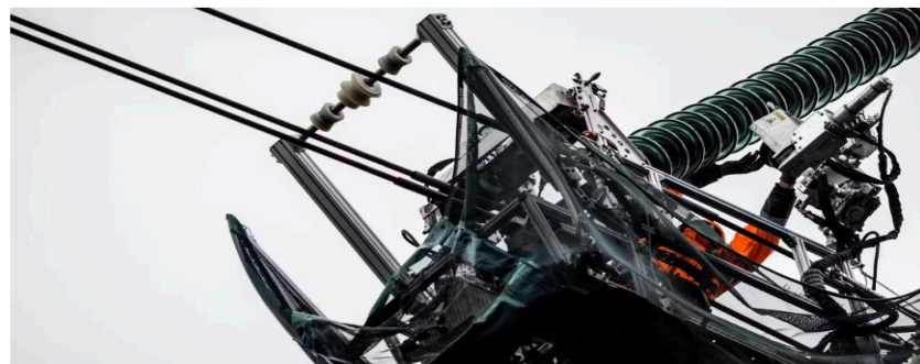
Werkzaamheden aan het stroomnetwerk door TenneT. Foto: Rob Engelaar/ANP
