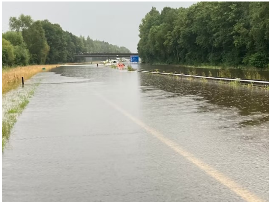
Figuur 28 Overstroming A1 ter hoogte van afrit De Lutte
