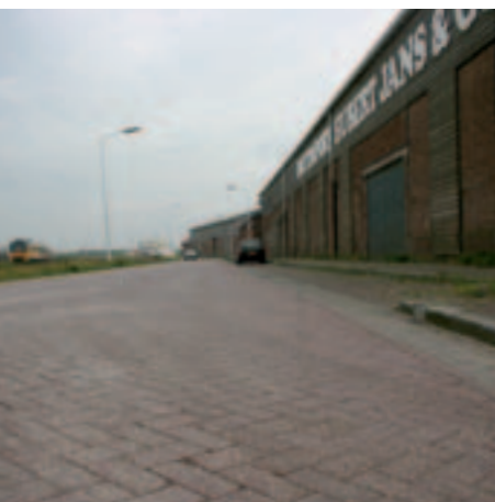
Duomix met elementverharding 6 jaar na aanleg
