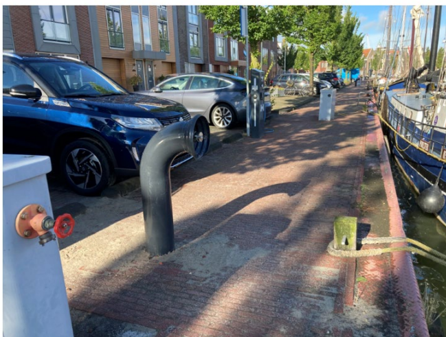
Periscoop pijp Harlingen met Camock 50 aansluiting
