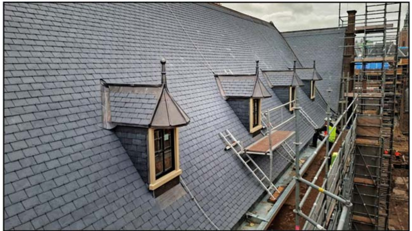
Het vervangen van 20.000 m 2 aan dakleien vraagt om schaars specialistisch personeel
