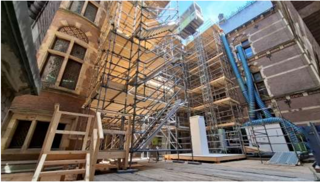
(Afbeelding 4: Proefsteiger gebouw J met de ingepakte lantaarn in het midden)
