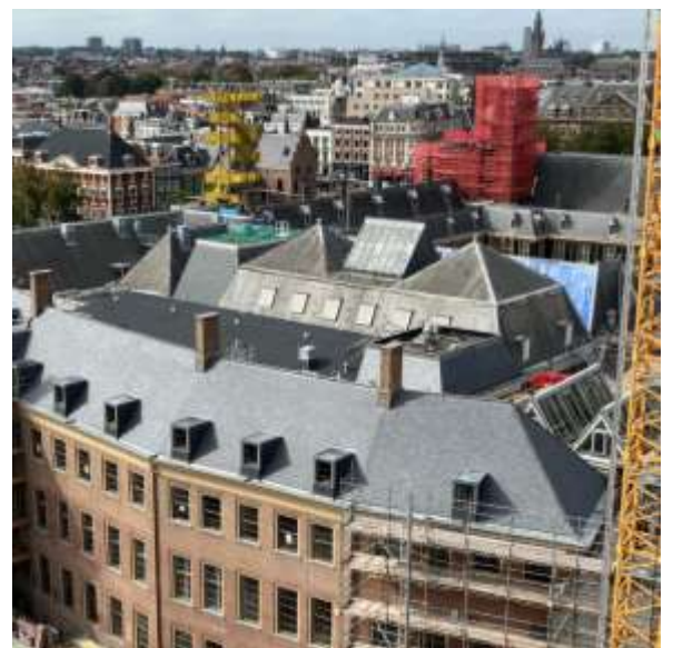
(afbeelding 3: Gebouw A, de werkzaamheden aan de gevels zijn afgerond)
