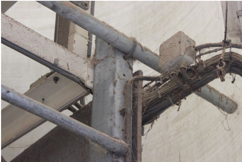
Figuur 2.32 Stof in een voederinstallatie (Bron: Brandweeracademie)
