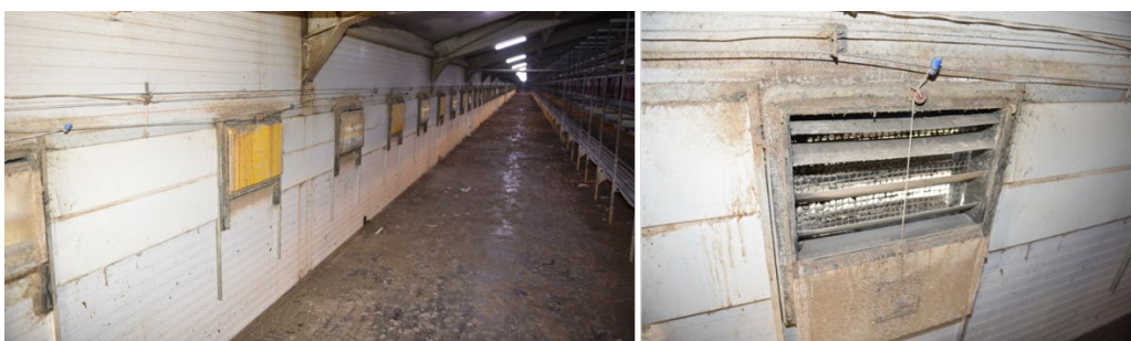
Figuur 3.3 Natuurlijke ventilatie in een leghennenstal als back-up systeem (Bron: Gelderland-Midden)
